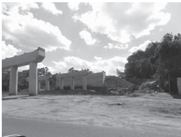
図 1-6. 大規模な道路建設
